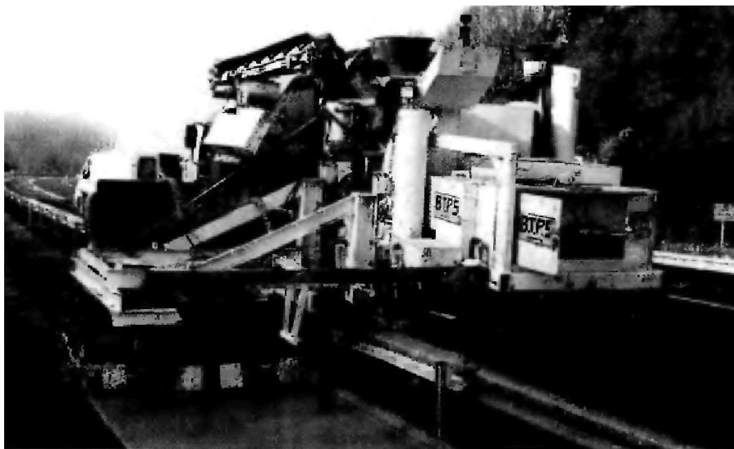
2.2 – сурет - Монолитті бетондау арқылы бүйір арналарын жөндеу
